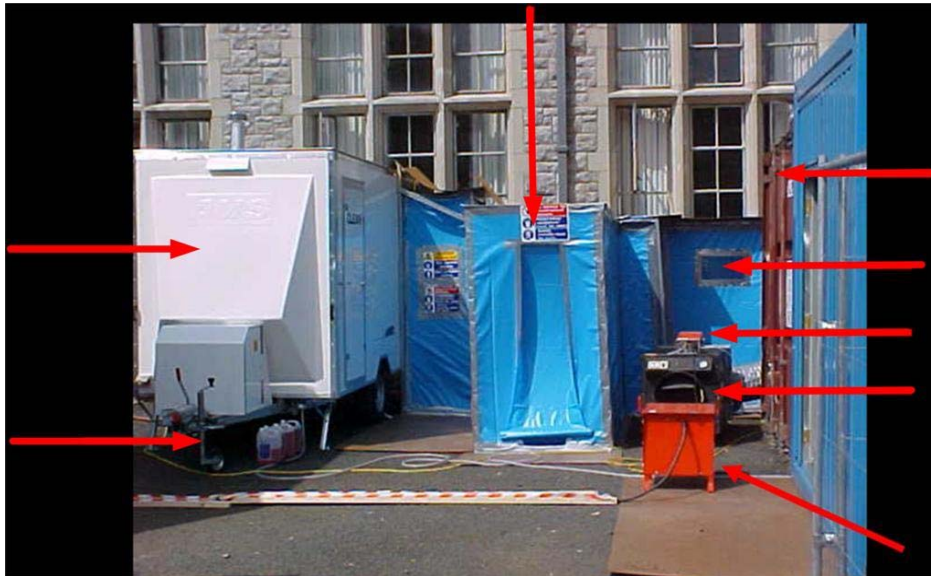
Fotografía 12.1 Entrada a un confinamiento, con flechas que señalan, siguiendo la dirección de las agujas del reloj, la cámara de aire para los residuos, el contenedor para los residuos, la ventanilla, el equipo de registro de presión, el sistema de depresión, el grupo electrógeno, las existencias de agente humectante y la unidad de descontaminación.
