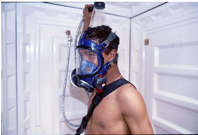
Fotografía 12.5 Descontaminación con un aspirador de clase H, en la ducha con el traje impermeable y ducha posterior antes de retirar el equipo de protección respiratoria (fotografías cedidas por el INRS; copyright INRS).
