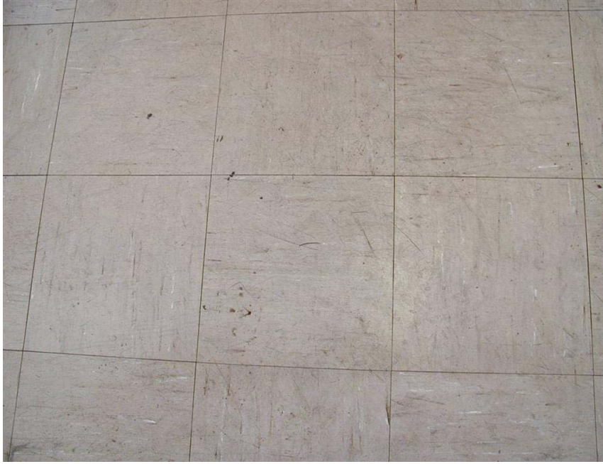
Fotografía 4.6 Losas de amianto.
