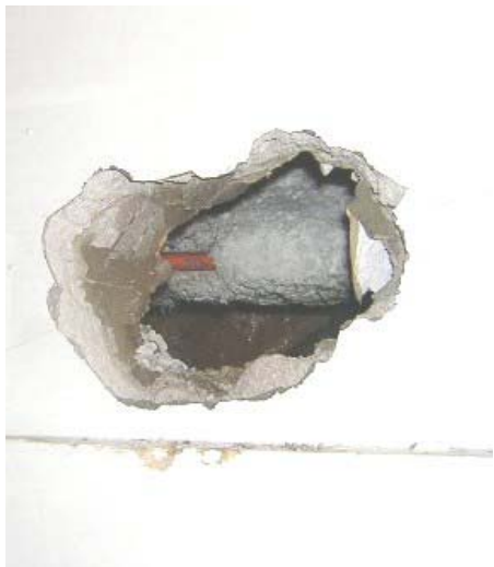
Fotografía 4.4. Pared perforada que deja ver el aislamiento de amianto de una tubería.
