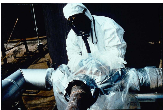
Fotografía 12.12 Bolsas con guantes utilizadas para la retirada controlada de un calorifugado de amianto (fotografías cedidas por el INRS; copyright INRS).
