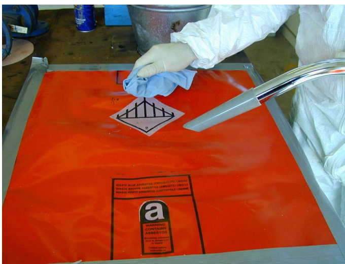
Fotografía 11.7 Limpieza minuciosa de la zona de trabajo con un aspirador de clase H y trapos húmedos.
