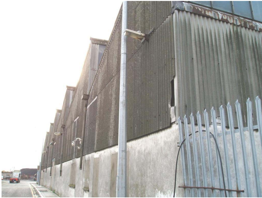
Fotografía 4.10 Revestimiento externo de fibrocemento en una fábrica.
