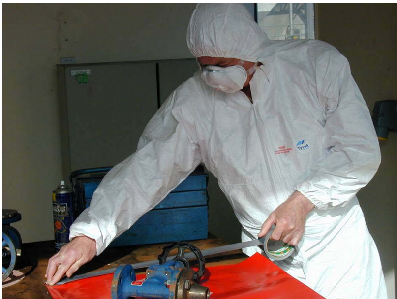
Fotografía 11.3 Utilización de cinta y láminas de polietileno para proteger el área de trabajo antes de limpiar las juntas de amianto de una válvula.
