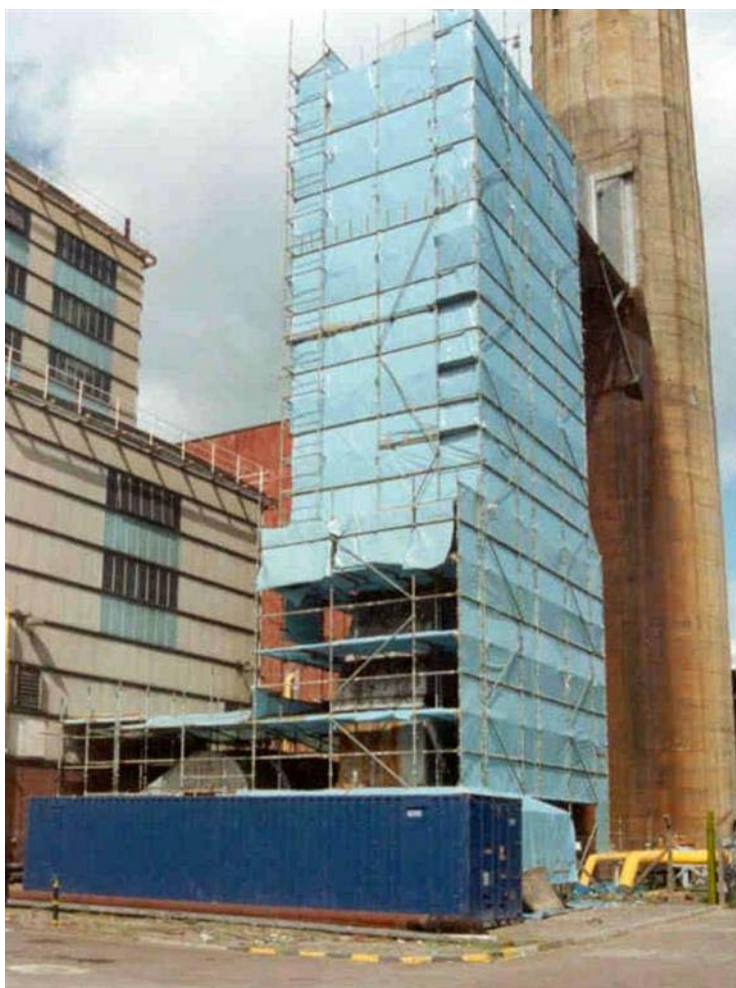
Fotografía 12.3 Confinamiento para la retirada del calorifugado de un conducto de gas.
