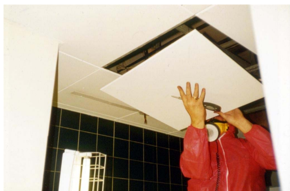
Fotografía 12.13 Retirada de una placa de amianto del techo adoptando las precauciones necesarias.
