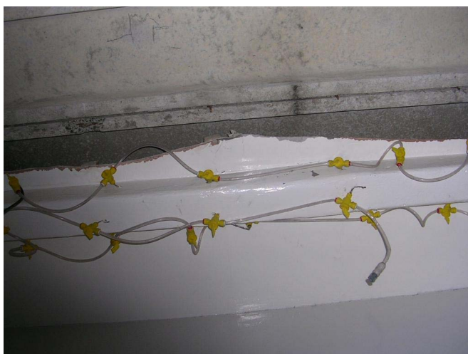
Fotografía 12.10 Ejemplo de sistema de inyección múltiple utilizado para humedecer aislamientos de amianto proyectado.
